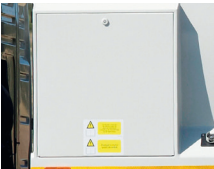
9 Elektrisch paneel, gebouwd in een waterdichte en makkelijk bereikbare kast.
